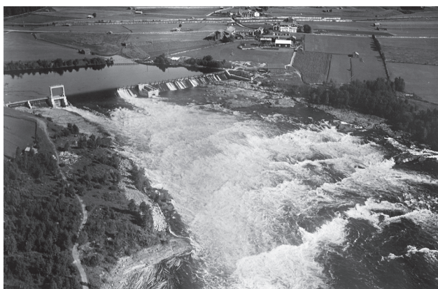
Norrfors kraftverk, regleringsdammen 1926-1931. Källa: SCA arkiv.
