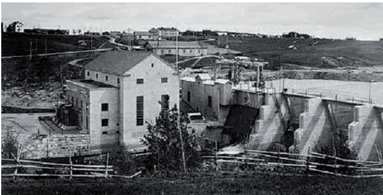
Norrfors kraftverk, föregångaren till Stornorrfors. Foto 1926-1931. Källa: SCA arkiv.
