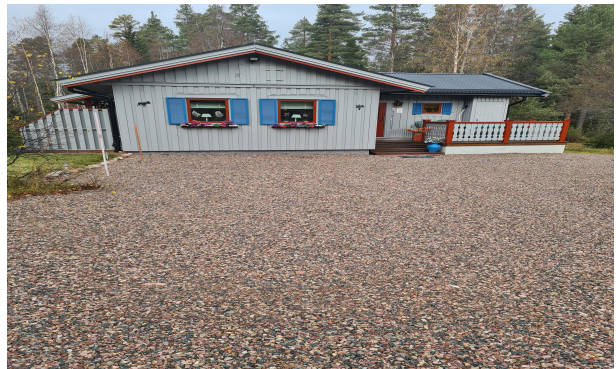
HUS NR 2 – OSTVÄGEN 145
