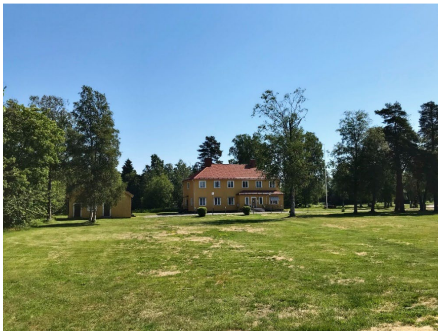
Figur 14. Prästgården och ytan mellan byggnaden och Industrivägen.
