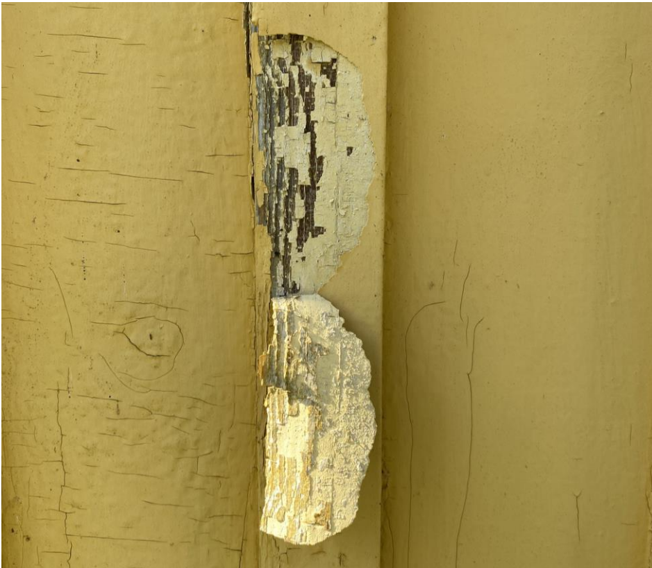
Bild 4 Detalj av fasaden. Den mörkare gula alkydfärgen flagar och under den syns en ljusare och mildare gul kulör och en färgtyp som bedöms vara linoljefärg.
