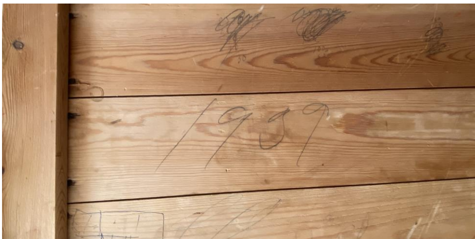
Bild 3 Blyertstext med byggnadsåret 1939 på väggen till vänster om trappan upp till vinden.
