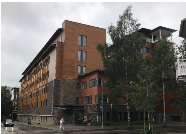
Figur 23. Byggnader inom fastigheten Embla 5, direkt sydväst om kvarteret Skruven. Foto: Tyréns AB 2019.
