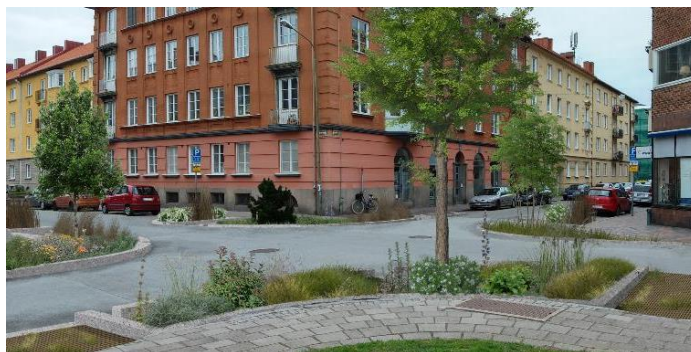
Figur 29. Exempel på nedsänkt stråk med kompletterad växtlighet. Bilden är tagen vid en korsning i Kristinelund.
