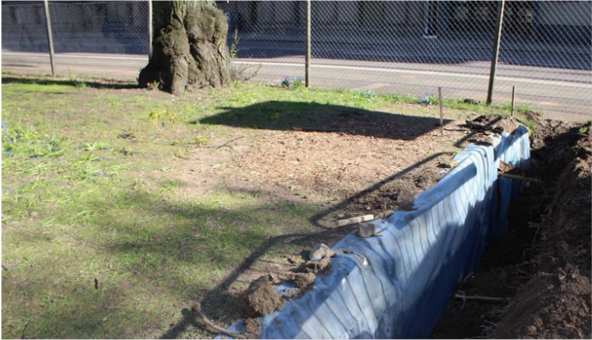
Figur 5. Rotdraperi av plast vid schaktvägg för att motverka uttorkning av jord och beskurna rötter.
