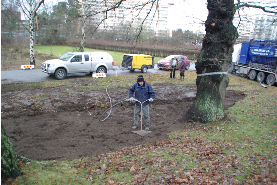
Figur 1. Luckring inför en markvitalisering
