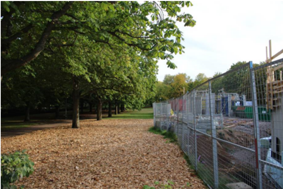
Figur 1. Skyddsstängsel och marktäckning (mulching) som skydd vid intilliggande byggnation.
