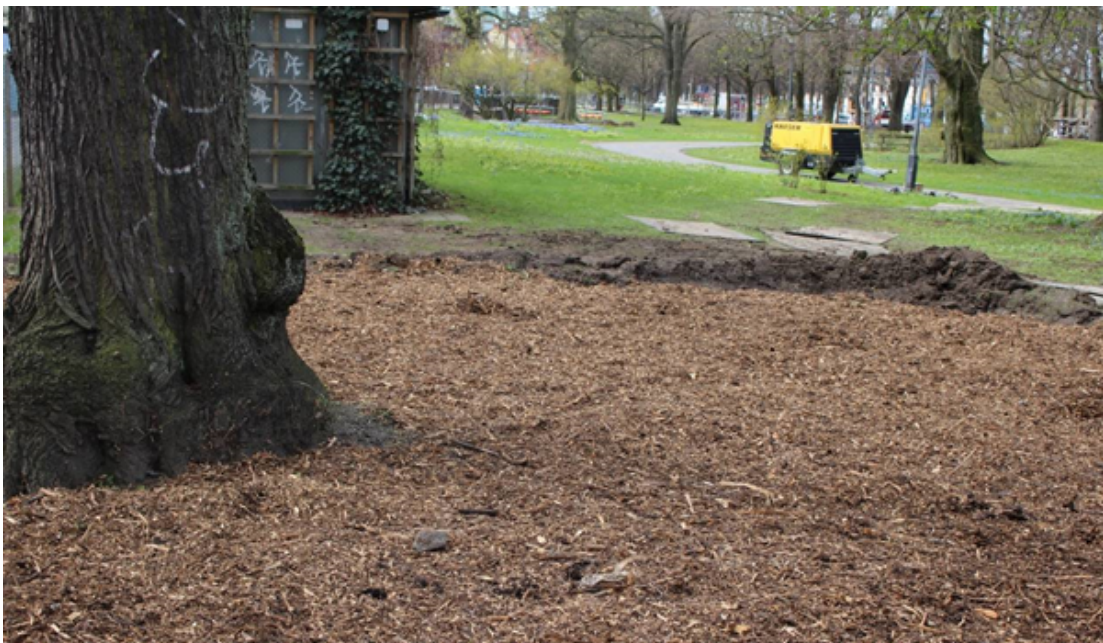
Figur 2. Färdigutlagt mulchlager vid markvitalisering.
