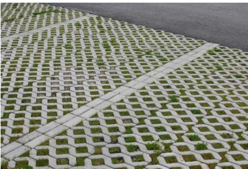
Figur 13. Exempel på genomsläpplig beläggning med hålsten.
